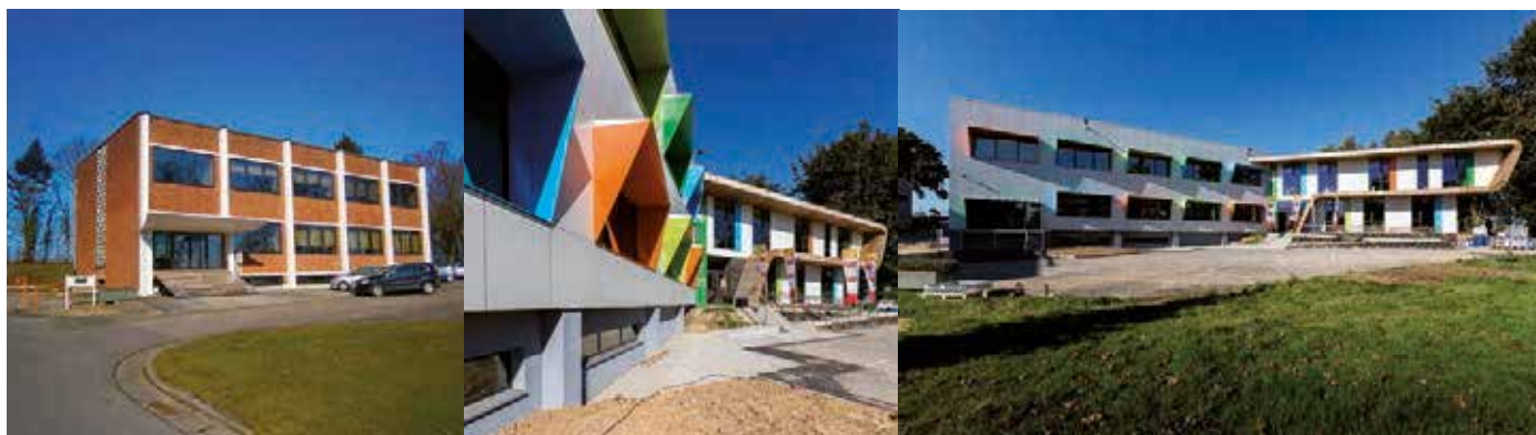
L'avant/après de ce projet situé à Limelette, qui a permis de rénover entièrement et de réenvelopper le bâtiment existant, lui ajoutant une extension contemporaine et colorée. © helium3
